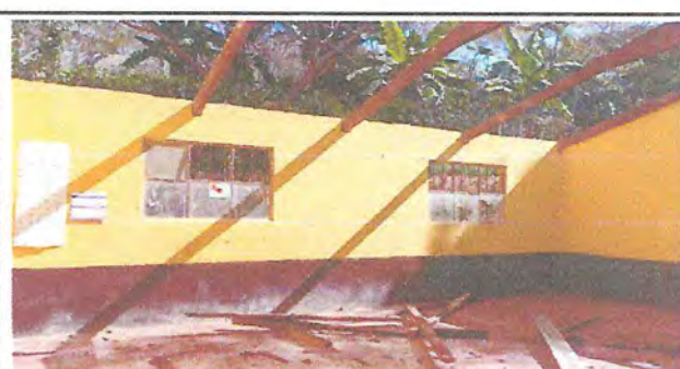
Foto 6: Desmantelado de estructura del techo de aula
