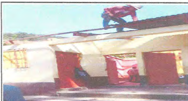
Foto 4: Desmantelado del techo
