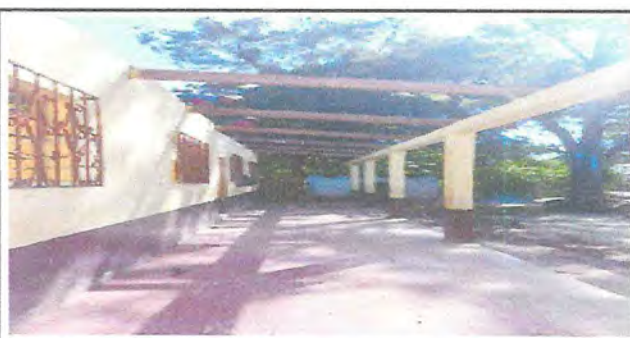
Foto 5: Desmantelado de estructura del techo de corredor
