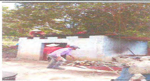
Foto13: Desmantelado de estructura de cocina
