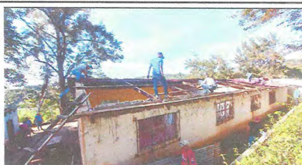
Foto 2: Desmantelado del techo
