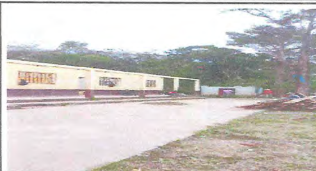
Foto 14: Desmantelado del techo de la Escuela
