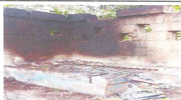
Foto 15: Desmantelado de plancha
