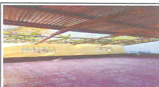
Foto 18: Desmantelado techo de aula
